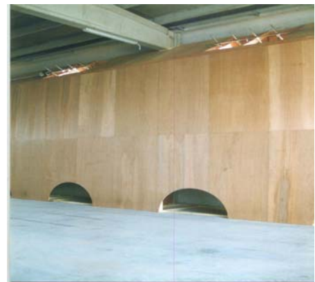
Halfronde openingen in de drukwand voor uitstroom lucht in beluchting kanalen. Aan de bovenkant van de drukwand luiken voor aanzuiging van interne lucht. Prefab drukwanden als optie in nieuwe of bestaande bewaarschuren.
