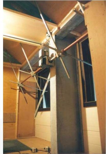
Drukkamer met mengluiken voor aanzuig buiten-, binnen- of menglucht.
