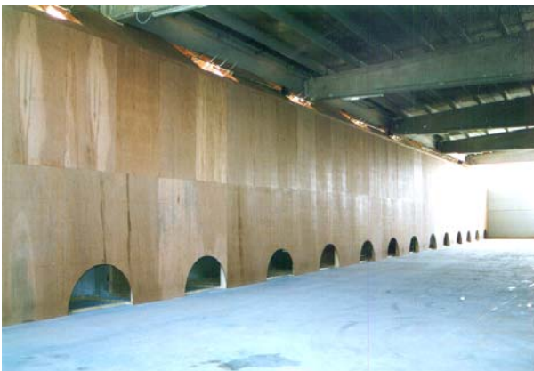
Halfronde openingen in de drukwand voor uitstroom lucht in beluchting kanalen. Aan de bovenkant van de drukwand luiken voor aanzuiging van interne lucht. Prefab drukwanden als optie in nieuwe of bestaande bewaarschuren.
