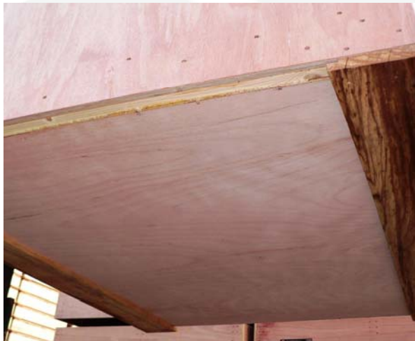
Onderkant pallet gesloten voor éénlaags beluchting.
